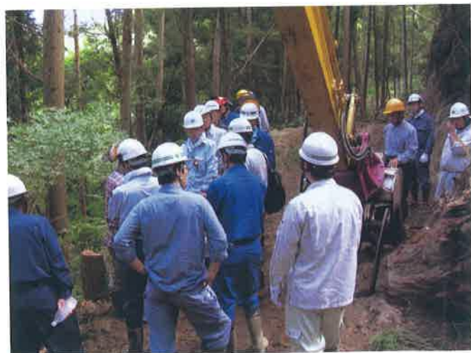
簡易作業道の作り方の実習
