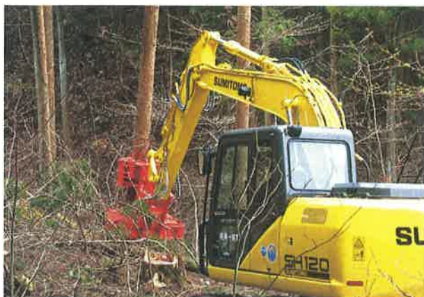
フェラーバンチャによる伐採
