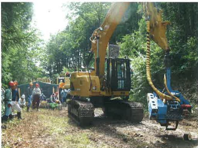
現場研修状況（ハーベスタ操作）
