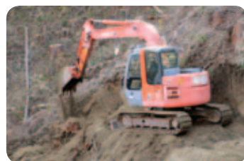
作業道開設状況
