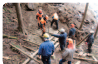
丸太組工を設置中の講師・研修生
