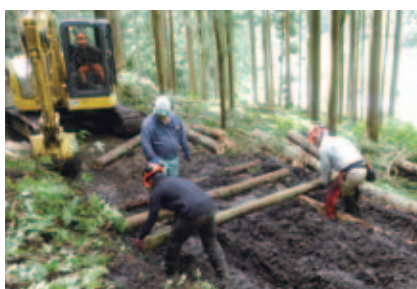
片梯子土台設置状況(横木設置)
