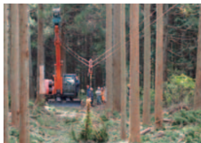
(班別研修) スイングヤーダ操作実習
