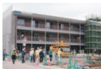
建設中の復興公営住宅
