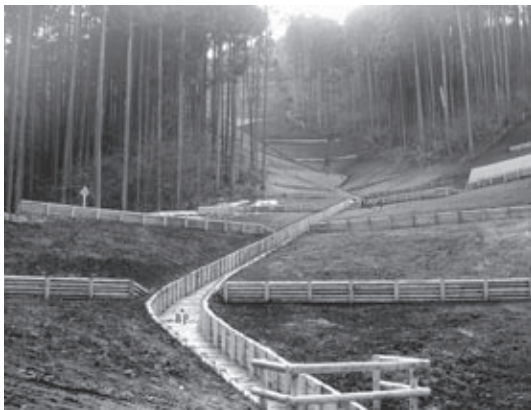
▲木製水路と木柵
