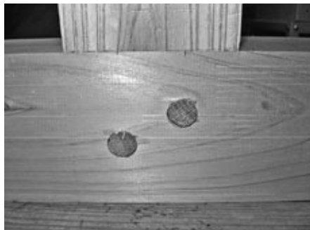
込み栓2本込み栓打ち (間隔20mm)
