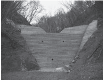
にらむ岩沢谷止工（木製型枠）西郷村 H21施工
