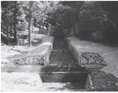
竜生保安林整備事業（木製谷止工・流路工）天栄村 H20施工
