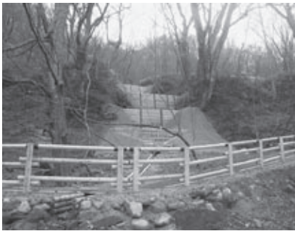
馬立治山工事（鋼製枠土留工・木柵工・木製手すり）西郷村 H21施工
