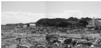
写真2 薄磯海岸の被災状況
