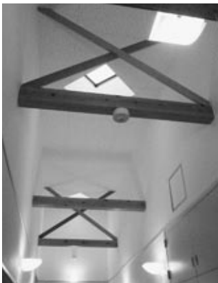
廊下には集成材の梁
