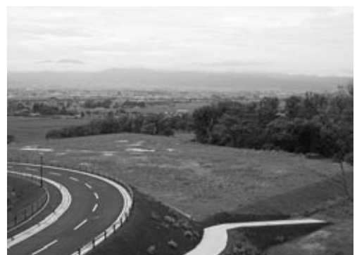
バイオマス発電施設建設地
