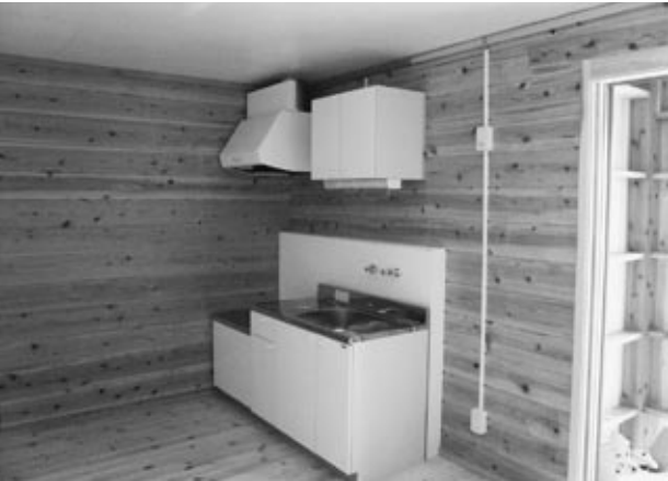
写真-3、4 ログハウスによる応急仮設住宅（外観、内装）
