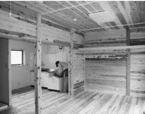
写真-5 伝統的工法（板倉工法）による応急仮設住宅（三春町）
