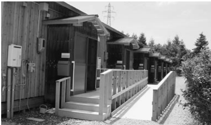
写真-1、2 縁側や車いす用スロープが付属した応急仮設住宅（三春の里）
