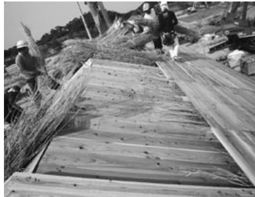
写真-6 伝統的工法による応急仮設住宅（いわき市）※断熱材としてカヤを使用
