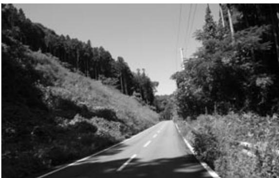
法面崩壊箇所が（左側）、完全に復元して安定している。起点側から約500m付近
