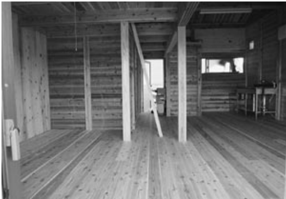
応急仮設住宅の内装
