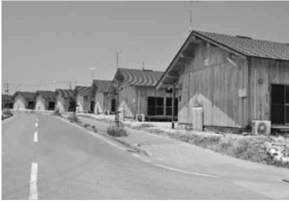
いわきニュータウンの木造応急仮設住宅団地外観
