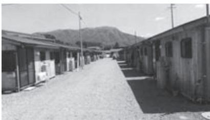
(写真2) 木造仮設住宅
