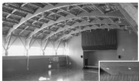
▲(写真1) 小野中学校屋内運動場1階
