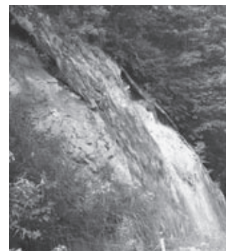
七ヶ岳線のモルタル吹付け工の施工現場
