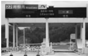
南相馬側インターチェンジ
