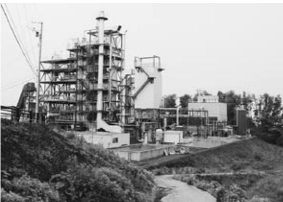
稼働が待たれる木質チップ燃料発電所
