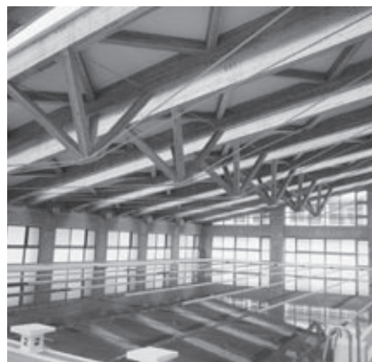
（写真2）大断面集成材使用室内プール
