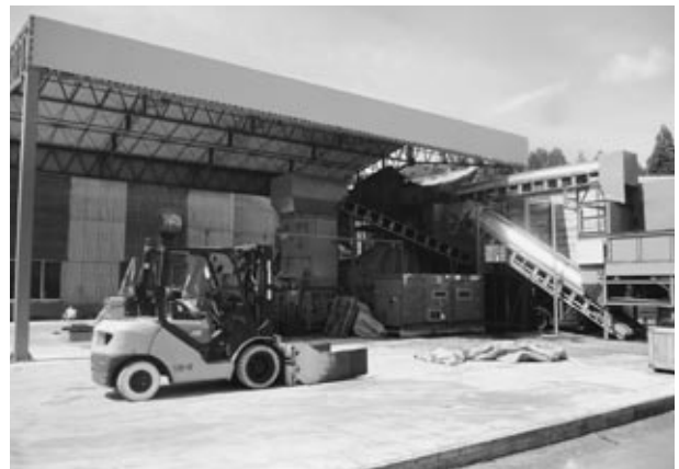
①ベラー(圧縮機)を配置した工場
