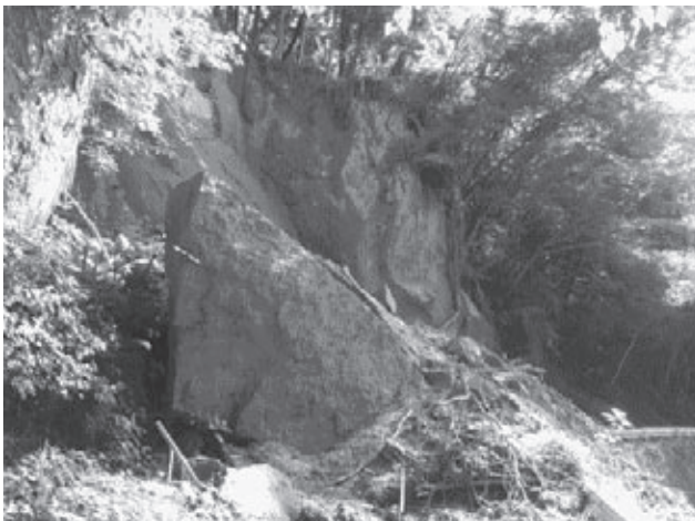
被災状況（法面崩落）
