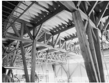
大断面集成材による製材工場
