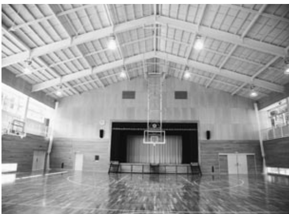
(写真2) 赤井中学校屋内運動場
