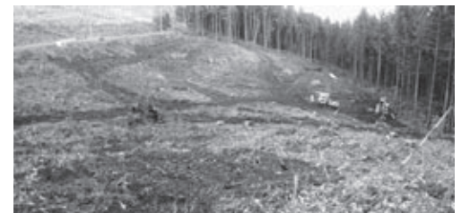
造成工事中の仮置場（古殿町）
