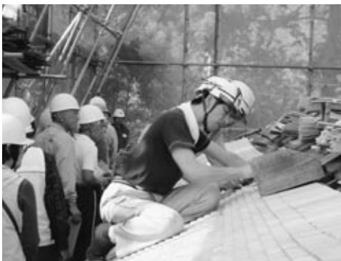
屋根の葺き替えの様子
