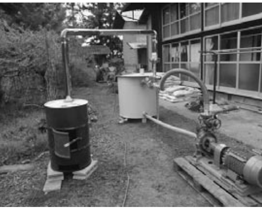
(写真3) 試運転2 伊達市農家にて自作ストーブに排煙処理装置を接続
