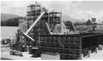
木質バイオマス利用施設
