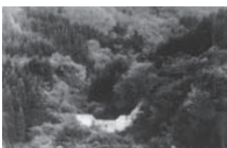
昭和46年度施行 南会津郡下郷町湯野上地内
