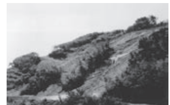
昭和52年度施行 郡山市南湖町浜路地内
