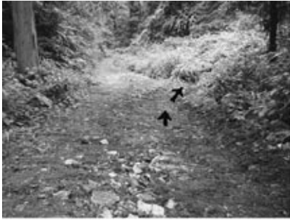
写真1 路面排水工施工例
