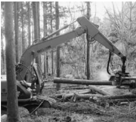
高性能林業機械による森林整備
