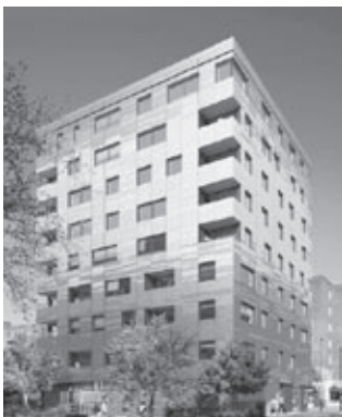
ロンドンで建築された9階建ての集合住宅 (林野庁提供)
