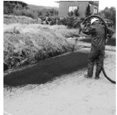
緑化基盤材吹付中
