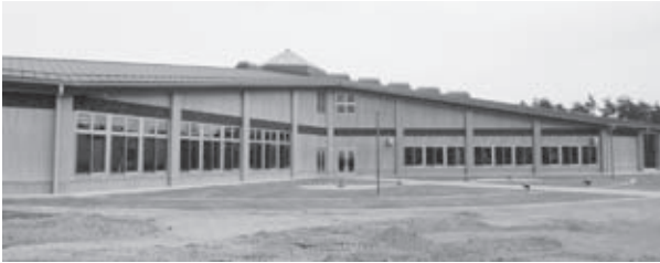
完成状況（外観）
