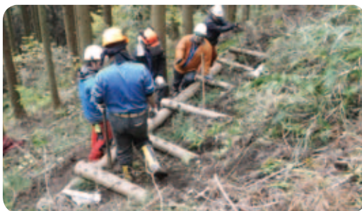
丸太組工を設置中の講師・研修生
