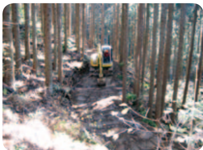
路盤整形中の研修生
