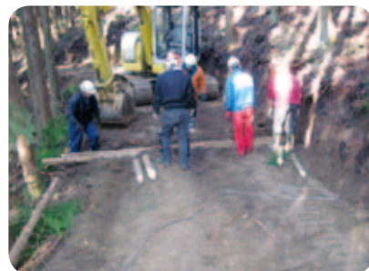
丸太横断溝工設置中
