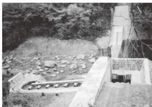
竣工時の苅倉地区の魚道付き治山ダム
