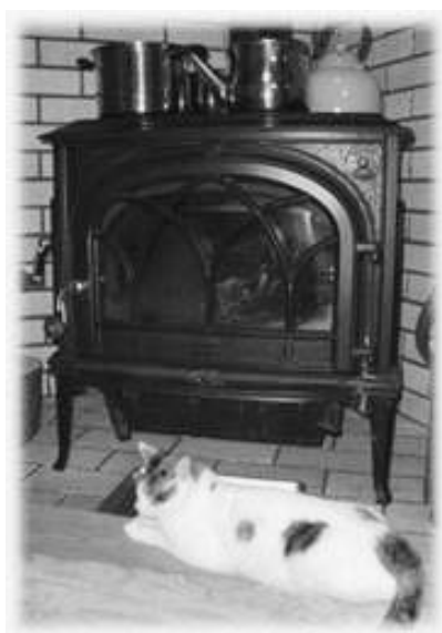
最近の薪ストーブは副次燃焼機能が付き熱効率が格段に向上しています
