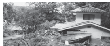
関東・東北豪雨災害（伊達市梁川町）
