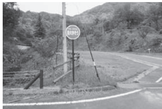
「湧水の里」駐車場の防火水槽
