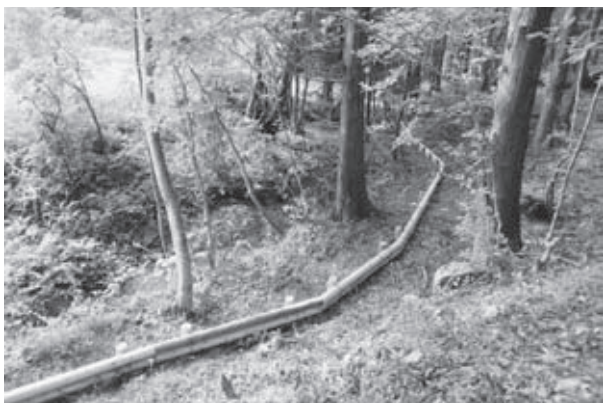
実証事業地の状況（放射性物質の拡散防止のための木柵工）
