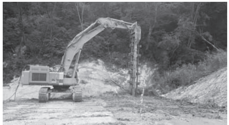
地盤改良工実施状況
