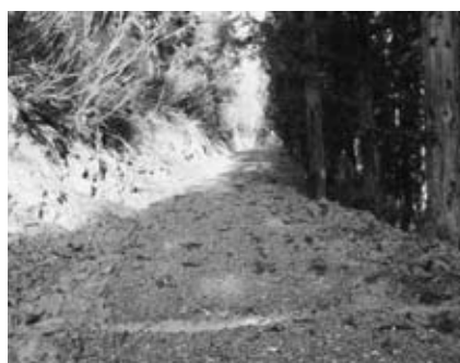
素堀り横断排水工
