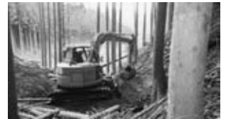
森林作業道作設研修掘削状況
