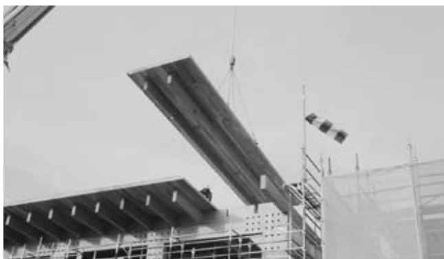
CLT パネル（屋根材）使用状況
