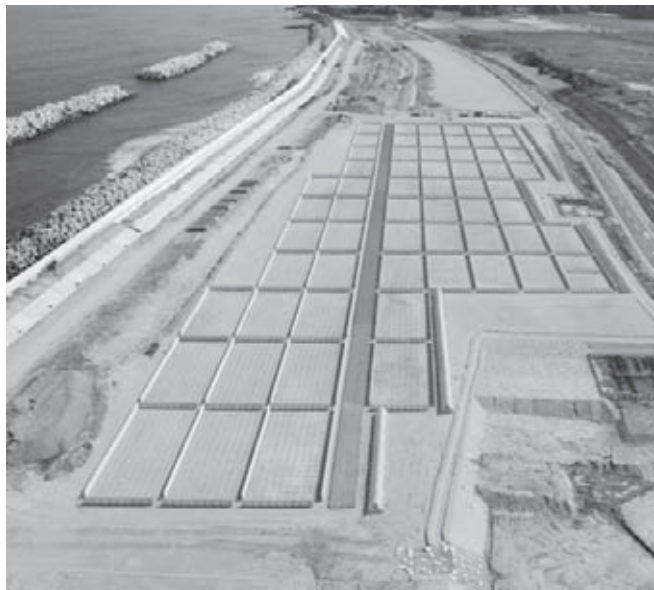
造成が進む海岸防災林
