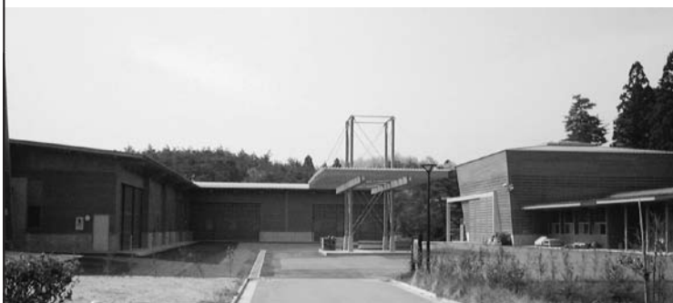
木材試験棟・加工棟全景
