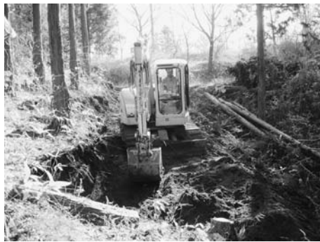
森林作業道作設中の研修生
