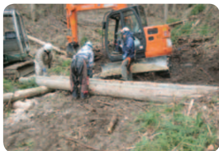
4日目：丸太水切排水溝施工
