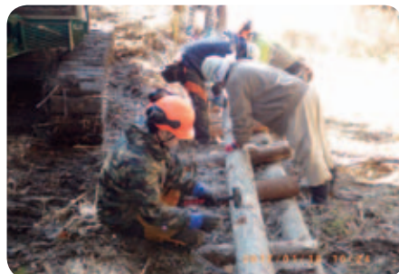
2日目：丸太組工施工
