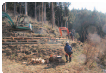
3日目：丸太組工施工
