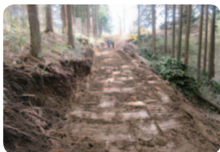
4日目：2班の作設完了状況
