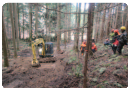
2日目：1班の作設状況
