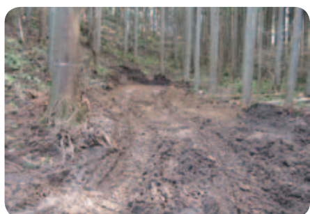
4日目：1班の作設完了状況
