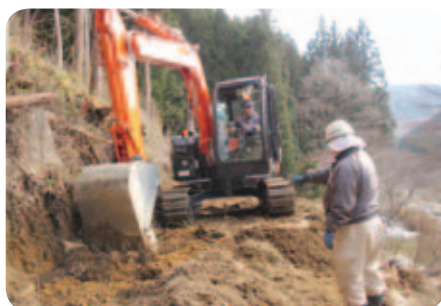
3日目：切土・盛土
