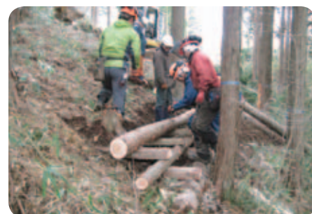
2日目：1班2班合同の丸太組工施工状況
