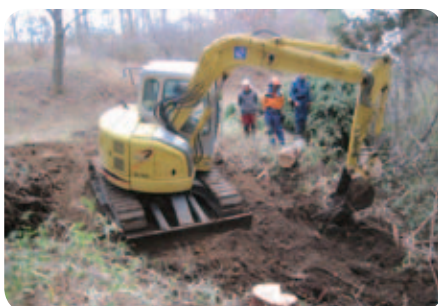
2日目：2班の作設状況
