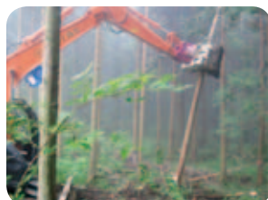
フラバンチャーザウルスロボの伐倒作業
