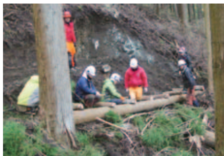
3日目：丸太組工（8寸釘打ち）
