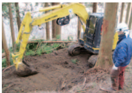
2日目：路盤転圧
