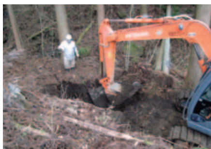
2日目：転石処理作業
