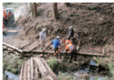
1日目：丸太組工施工
