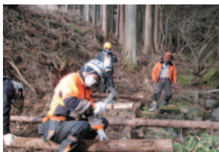
1日目：丸太組工（8寸釘打ち）
