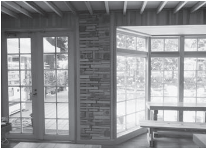
福島県産材による内装木質化
