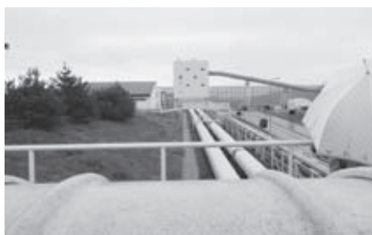
原町火力発電所 (石炭と木材チップを送るパイプライン)
