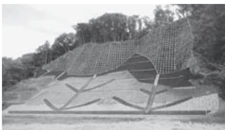
農林水産大臣賞を受賞した 復旧治山2801工事（上日影地区）
