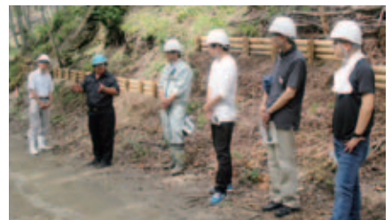
現場作業についての説明を受ける
