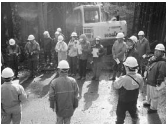
現地検討状況
