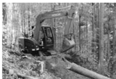
作業道初級研修 バックホウによる実習
