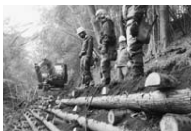
作業道上級研修 丸太組工の実習
