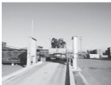
(1)トラックスケール用検知装置
