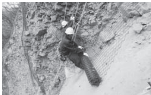
コボ一沢施工中写真 (近景)
