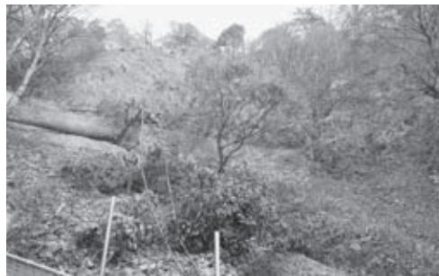
コボ一沢施工中写真 (遠景)
