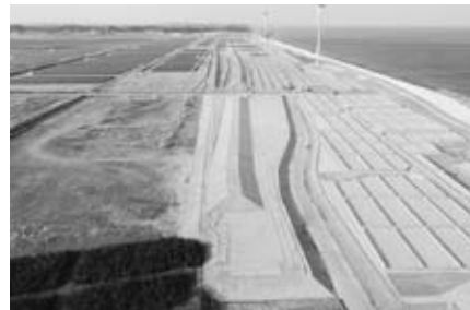
「一本松」周辺の海岸防災林復旧
