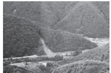
平成23年新潟・福島豪雨災害の状況
