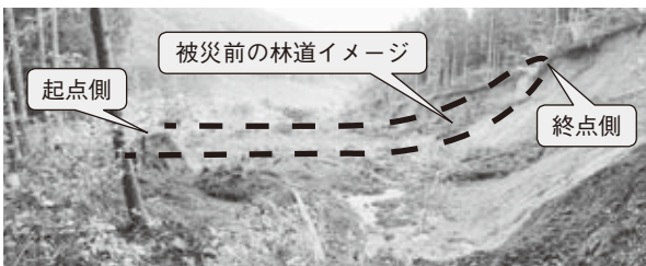
(写真4 林地崩壊に伴う路体の流失)
