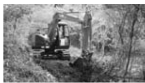
作業道初級研修 バックホウによる実習
