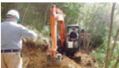
豊田講師からアドバイスを受けながら機械を操作し作設する
