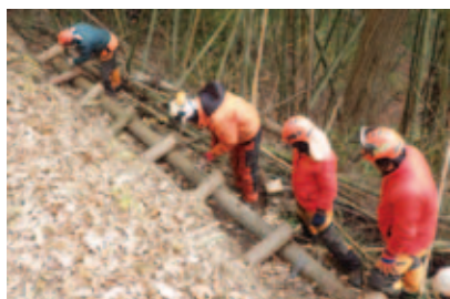
丸太組工の作設実習
