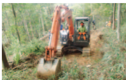
森林作業道作設実習
