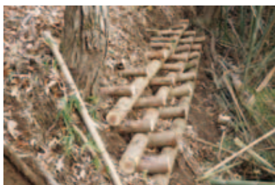
完成した丸太組工
