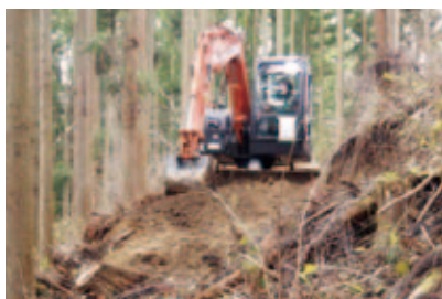
バックホウを使用しての作業実習
