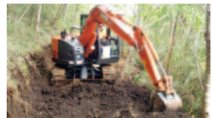
バックホウを使用している作業実習
