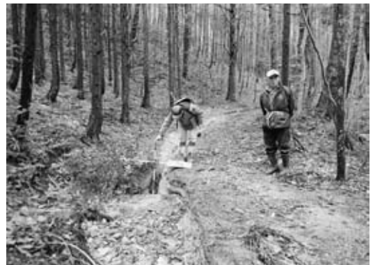
森林所有者と森林作業道の洗掘状況を確認
