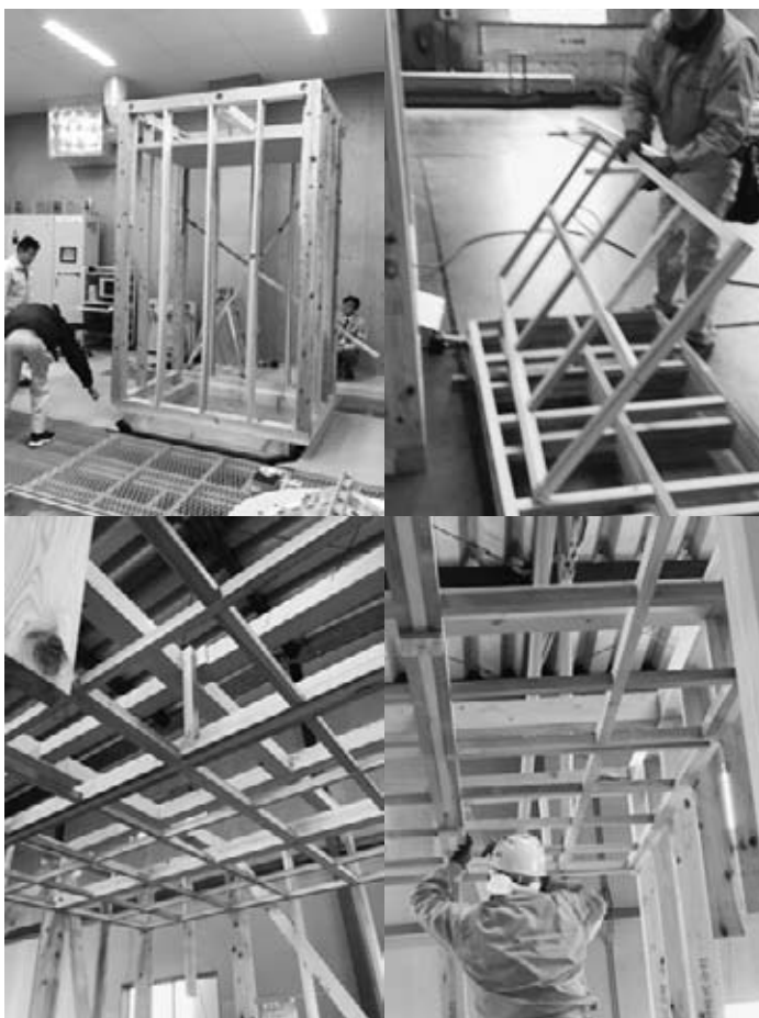
野縁ユニットの振動実験と施工の様子
