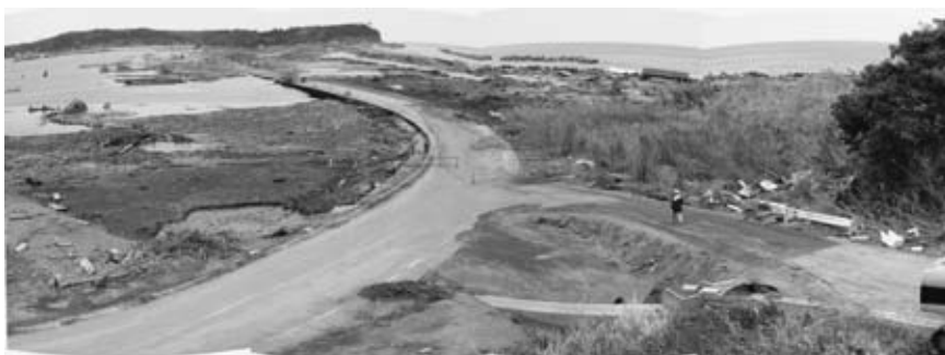
被災状況 鹿島地区（南相馬市）
