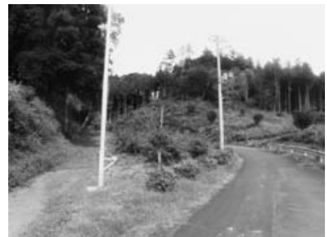
里山の再生整備（施工後・現在）
